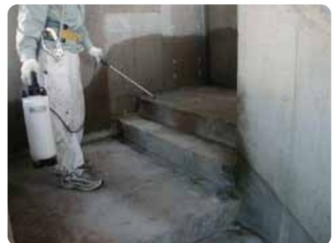
噴霧器による施工
